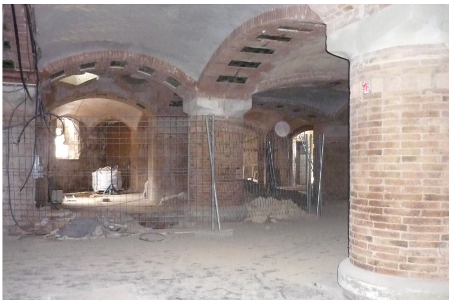
Sala al semisoterrani del Pavelló de l'Administració
