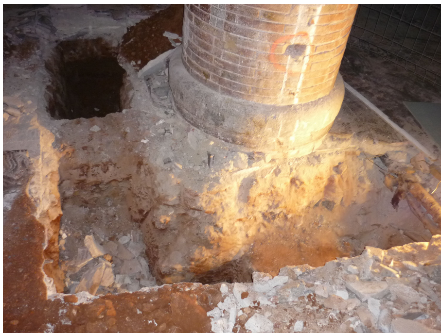
Vista general del sondeig
